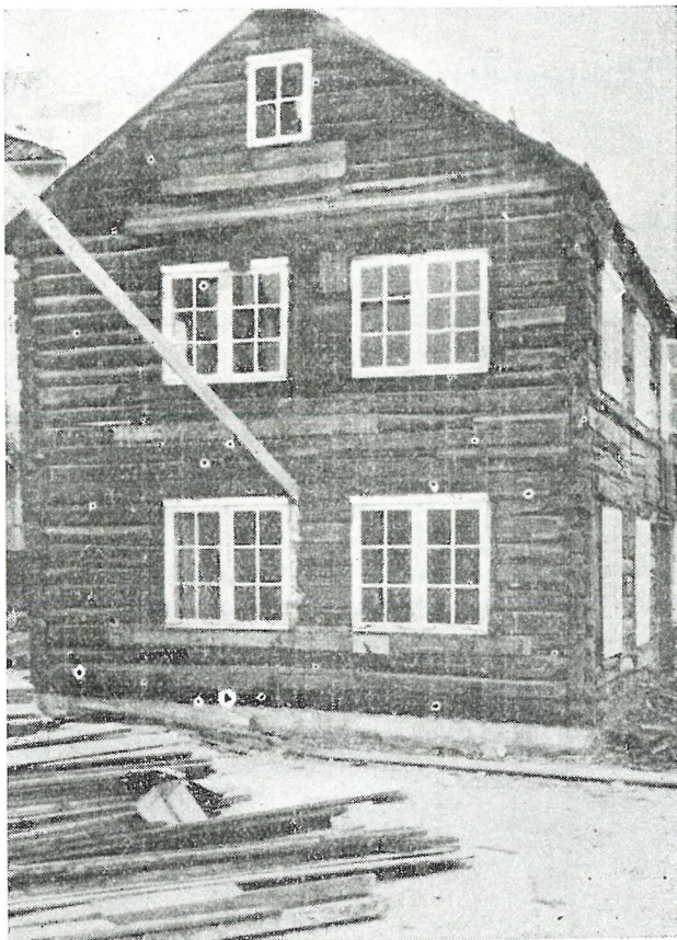
Veggen mot sydost og det lille smug ved Jørgen Peders eiendom like etter at kledningen er fjernet
